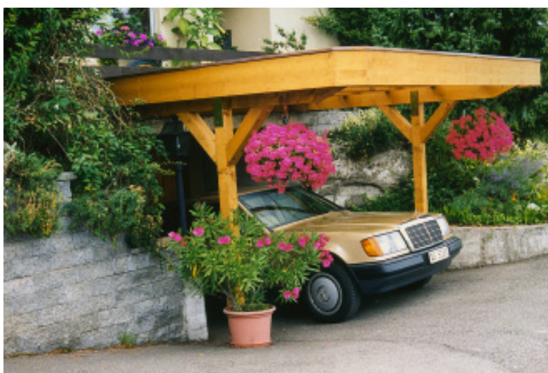
Couverture intégrée dans l'entrée du garage
