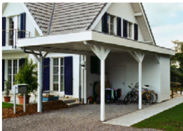
Carport avec réduit
