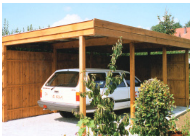
Carport avec parois latérale et arrière
