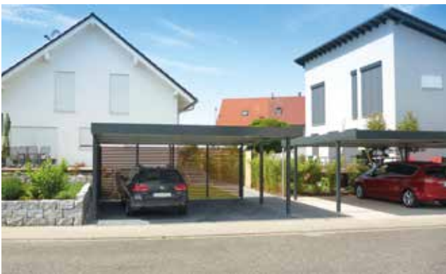
06 Einzel- und Anbaucarport. Einzelcarport mit Sektionaltor und Wandelementen in Optik „blickdichte Holzlattung“
