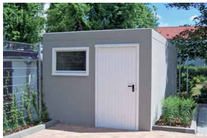
fenêtre imposte et porte de service séparée
